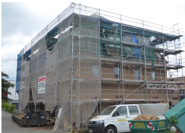
Die Nordwestseite des Hauptflügels während der Dachinstandsetzung im Mai 2022.
