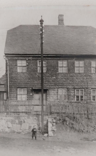
Strommast vor Scheibenstraße 67 (Ost)
