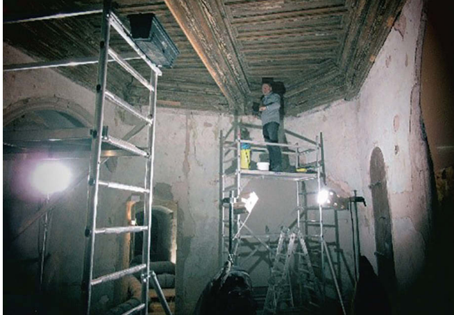
Restaurierungsarbeiten im Raum 2.1 des Nordflügels
